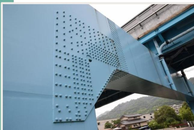
■ 鋼製橋脚隅角部疲労対策工
