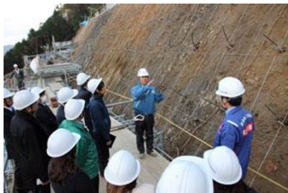
急斜面の養生の施工状況を見学
