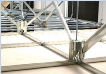
TV・新聞・雑誌等で紹介される建物の「耐震化」とは、建物自体(構造体)が、大地震でも倒壊しないようにすること。非構造部材である天井についてはその十分な対策がなされてきませんでした。当社は業界でいち早く「天井耐震化」に取り組み、研究・開発を重ね耐震天井を創り上げました。東日本大震災後は天井耐震対策の規制が強化され、様々な建物に当社の耐震天井が採用されています。
