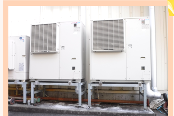
医薬品製造原料及びサンプル品の温度管理庫 (ECOV-D37WA1/UCL-D5VHA/RBS-P20HRC-Q)
