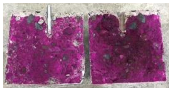
あと施工アンカーが打設されたコンクリート
