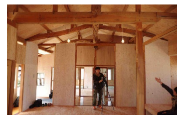
空き屋改修-移住者促進住宅
